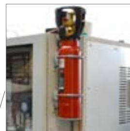
DISPOSITIVO DI SPEGNIMENTO DEGLI INCENDI A CO 2
